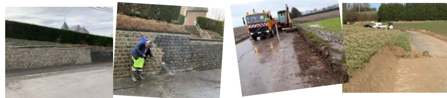
Nettoyage du mur de l'église de Lens-sur-Geer
